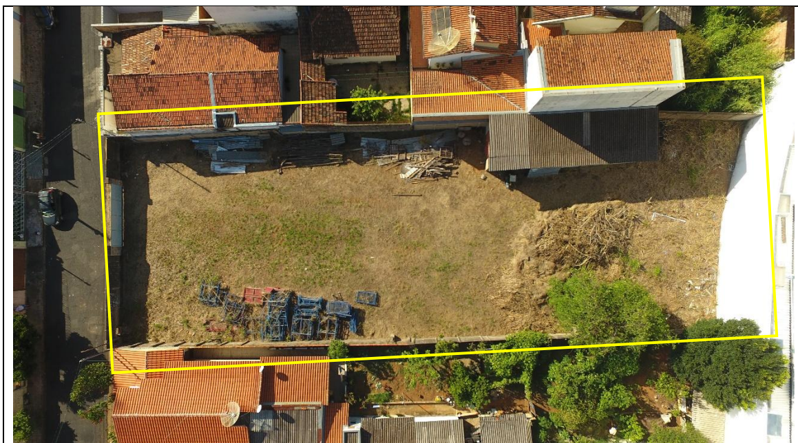
Figura 21: Área do terreno pronta para início da construção.
