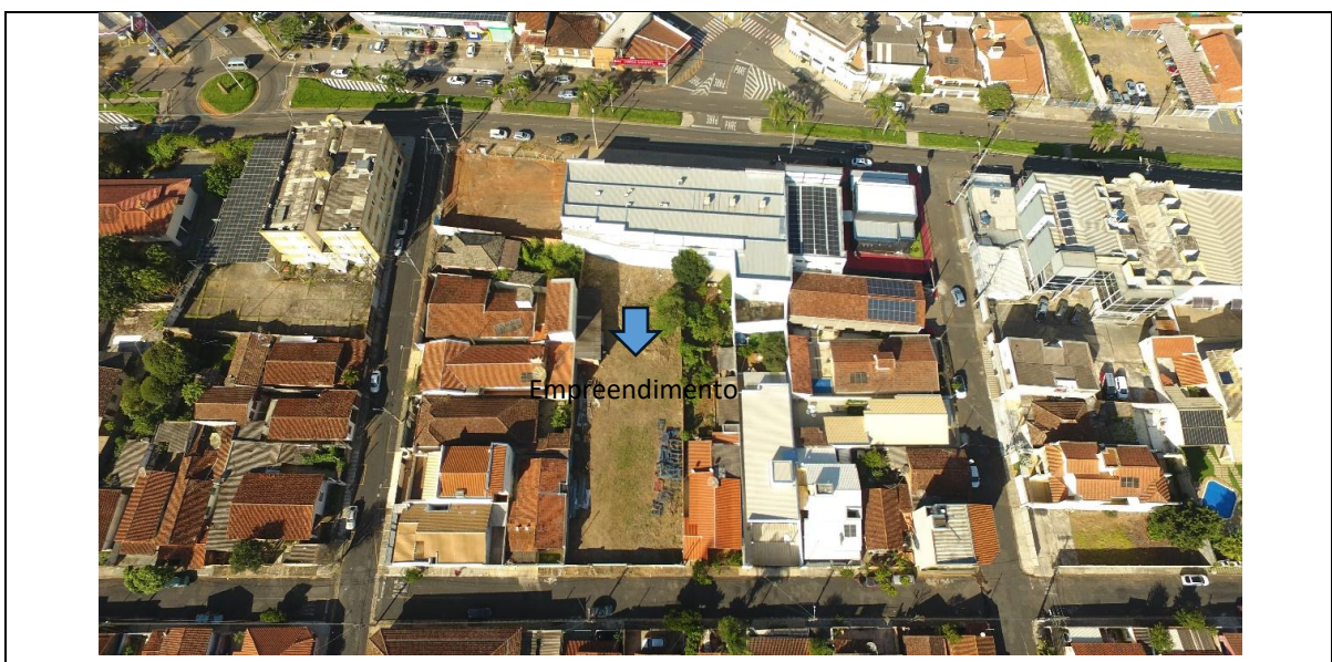
Figura 22: Sistema de microdrenagem no entorno
